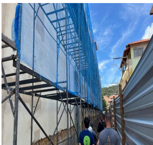
Andaimes para mapeamento e reforço das peças estruturais externas.
