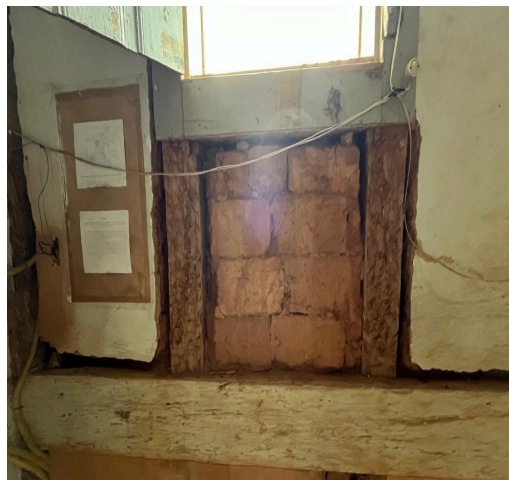
Mapeamento das peças estruturais internas do consistório.
